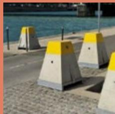
Installation de dispositifs visant à entraver toute intrusion de véhicules béliers\* : bornes en béton utilisées en chicane, dispositifs amovibles...
